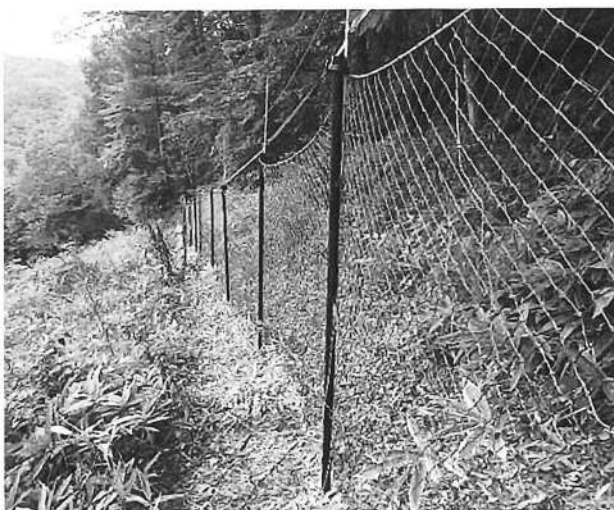
図2 本手法で設置した柵の管理道
