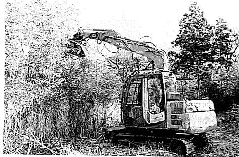
マルチャーによる施工状況
