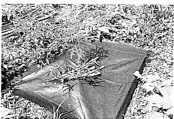
防草シートの設置状況
