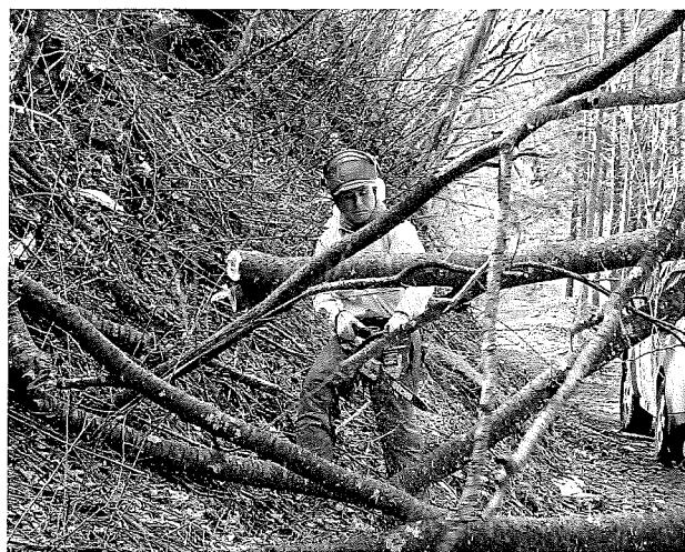
烏淵県有林に接する道に倒れた樹木の伐採・撤去作業の様子
