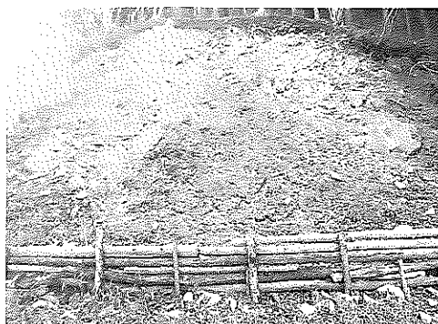
石田さん手作業の法尻丸太柵工 (榛名県有林内 林道蛇ヶ岳線地内)
