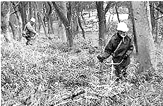
森林内の刈り払い作業の状況
