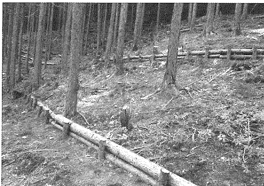
筋工により表土流出を防止する取組
