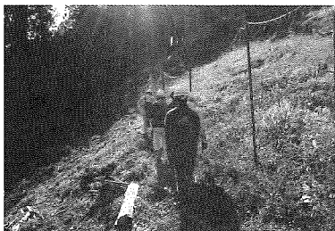
獣害防止柵の設置状況確認
