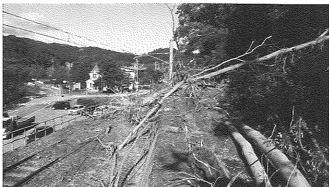
嬭恋村 JR吾妻線の被災状況
