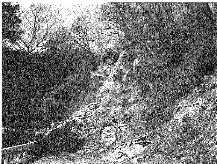
法面復旧工事中 林道奥山六車線（南牧村）
