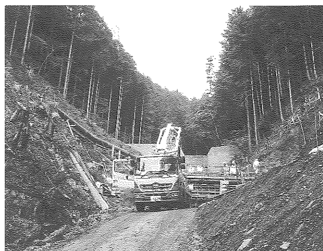
H27年度施工中の谷止工(奥はH26年度完成)
