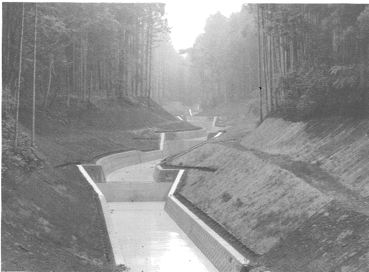
平成26年度森林土木写真コンクール (題名)「復旧治山事業」
