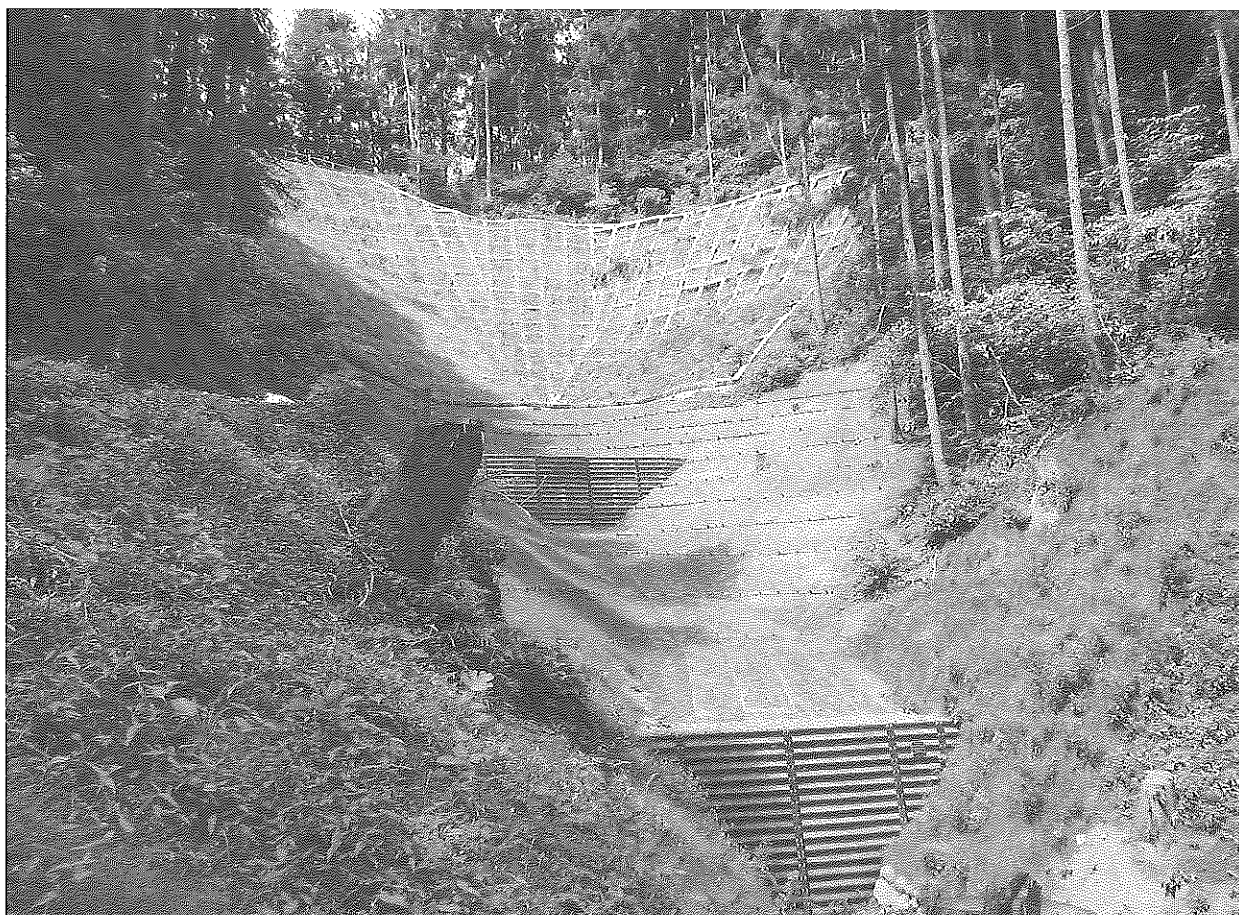
平成28年度森林土木写真コンクール (題名 山腹工事完成)
